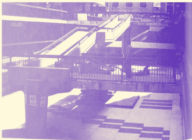
Los bajos de Aurrerá, ca. 1980, epicentro de emblemáticos bares de copas madrileños. En esta zona estuvo antes el Asilo del Cristo de la Victoria.
